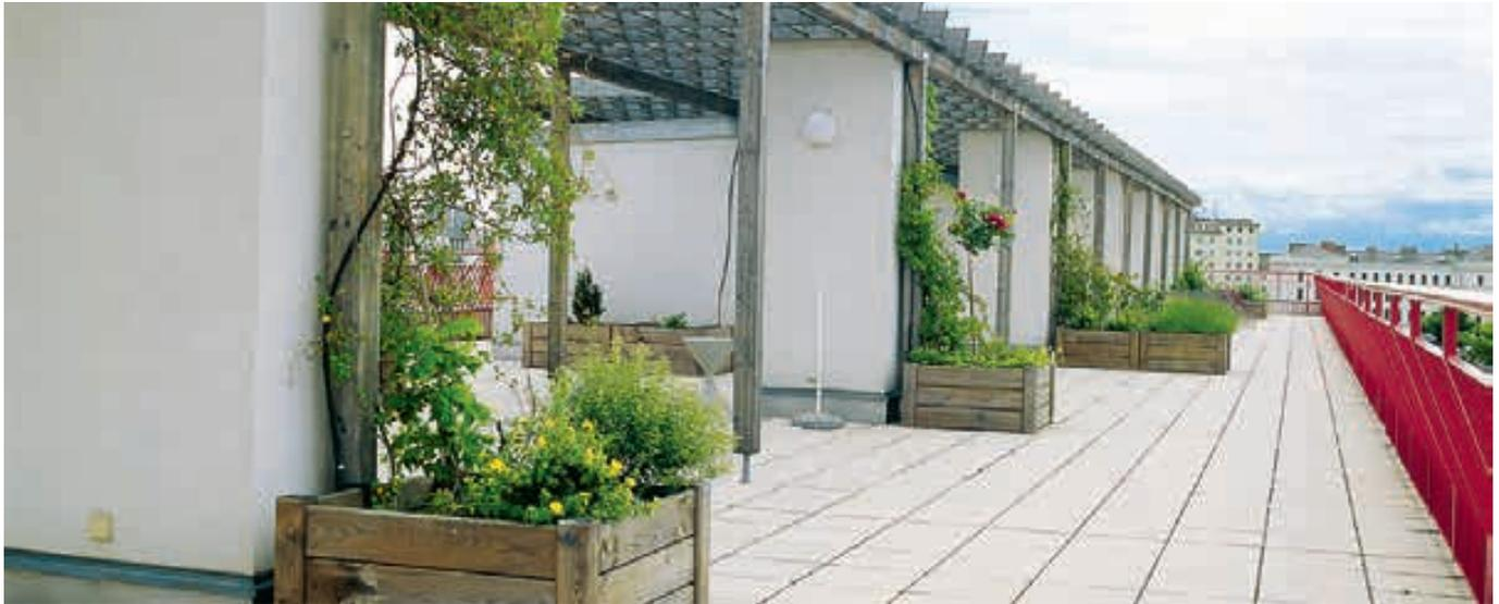
Nicht nur über den Dächern, sondern auch oberhalb von Kellern, Erkern etc. kommt diese beliebte Art des Umkehrdaches zur Anwendung. Die begehbaren Platten können entweder in einer Bettungsschicht aus Kies, auf Plattenlager oder gleich auf Austrotherm XPS® TOP 30 Streifen gelagert bzw. verlegt werden. Je nach Gestaltung sind beliebige Terrassenplatten einsetzbar.
