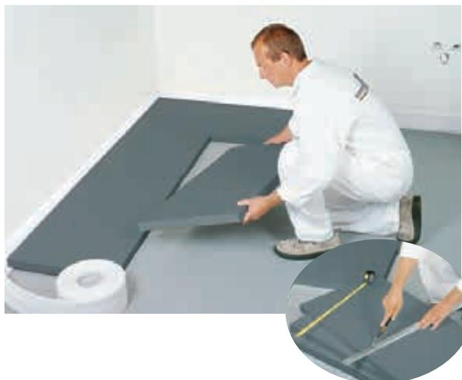
Die optimale Lösung zur Trittschalldämmung von Geschößdecken stellt Austrotherm EPS® T 650-PLUS dar. Dabei werden am besten sämtliche Installationsleitungen bzw. -rohre zwischen 2 bis 3 cm dicken Austrotherm EPS® W20-PLUS Dämmplatten angeordnet. Darüber wird die entsprechende Austrotherm EPS® T 650-PLUS Dämmplatte je nach Trittschallanforderung verlegt. Bei Bedarf kann Austrotherm EPS® T 1000-PLUS Trittschalldämmplatte für Gesamtbelastungen bis 1.000 kg/m<sup>2</sup> eingesetzt werden.
