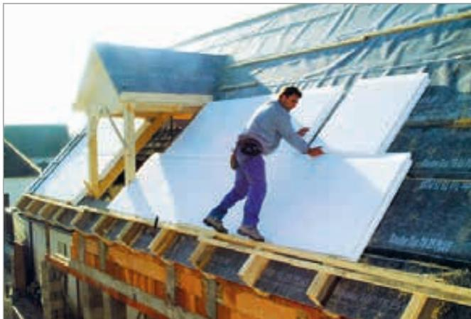
Im Gegensatz zur Zwischensparrendämmung wird eine vollständig homogene Dämmdicke über die gesamte Dachfläche erreicht. Weiterer Vorteil: die Tragkonstruktion des Dachstuhles bleibt sichtbar. Gute Schallschutzwerte bei einer Auflegung einer 40 mm dicken Sichtschalung mit Doppelnut.
