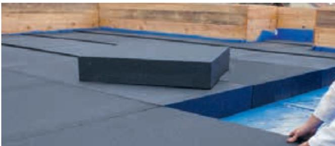
Bestens geeignet für extrem leichte und vorgefertigte Gefälleausbildungen am Flachdach. Wärmeleitfähigkeit:  $\lambda_D = 0,030 \text{ W/(mK)}$
