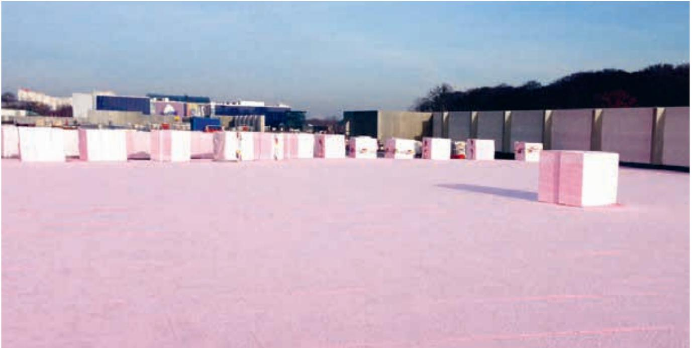
Das Umkehrdach ist eine Flachdachkonstruktion, deren wesentliches Merkmal – im Gegensatz zu herkömmlichen Flachdachkonstruktionen – die über der Feuchtigkeitsabdichtung liegende Wärmedämmung ist. Möglich wurde diese Konstruktion erst durch die Entwicklung von Dämmstoffen, die praktisch kein Wasser aufnehmen. Diese Dachkonstruktion besteht vor allem durch drei Merkmale: Sicherheit, Einfachheit und Wirtschaftlichkeit.
