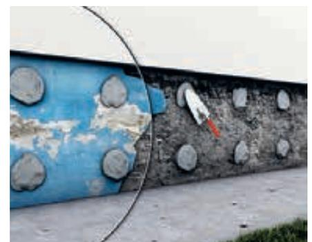
Vor dem Verkleben mit dem Austrotherm Sockelschutzelement werden ca. 2 cm dicke „Kleberpatzen“ angeworfen.
