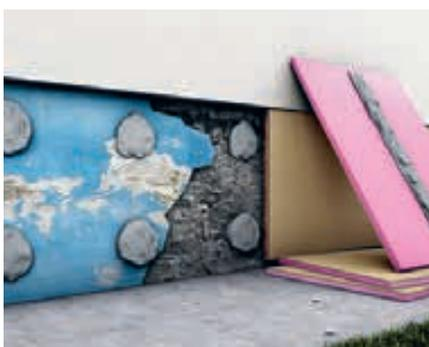
In der Mitte des Austrotherm Sockelschutzelementes einen Streifen in der Längsrichtung auftragen und dann an die Wand anbringen
