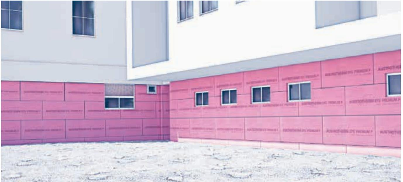
Durch punktweises Anbringen eines lösungsmittelfreien Klebers (Bitumen oder Kunststoff) werden die Platten direkt auf die Feuchtigkeitsabdichtung geklebt. Üblicherweise werden Austrotherm XPS® Dämmplatten mit Stufenfalz im Verband versetzt angebracht. Kreuzstöße sind möglichst zu vermeiden.
