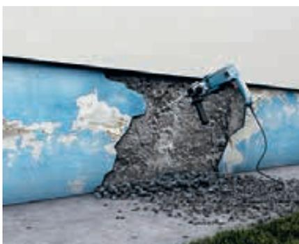
Lösen Putz abschlagen bzw. bei bestehenden Altputz ausreichende Tragfähigkeit prüfen.
