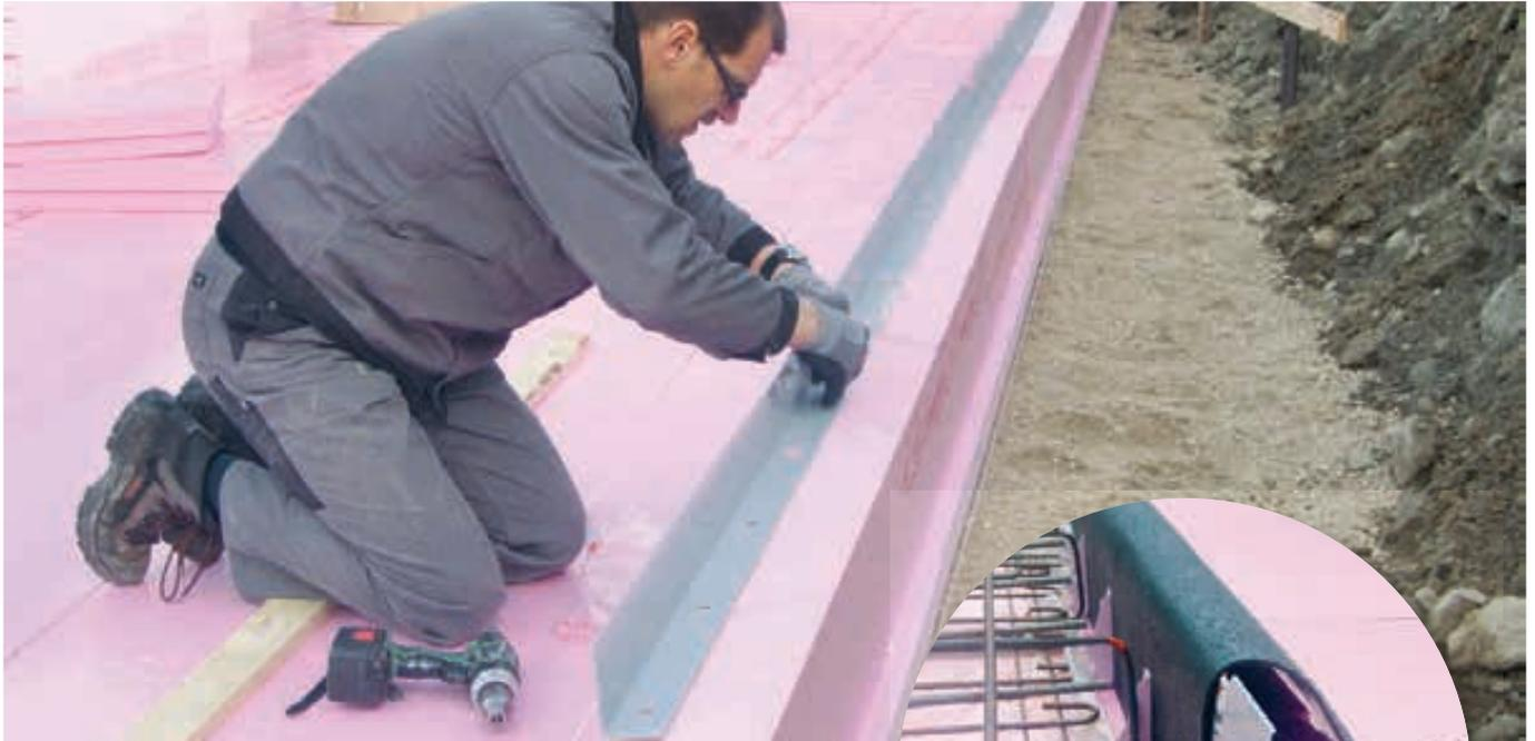
Um ein Gebäude vor Kälte zu schützen, bringt man am besten gleich dort die Wärmedämmung an, wo der Kontakt zum kalten Untergrund und feuchtebelastetem Erdbereich am größten ist: im Fundament und Keller. Um das Risiko von Wärmebrücken in diesem Bereich zu vermeiden, ist eine optimale Wärmedämmung zu empfehlen. Das Austrotherm Fundamentplatten-Dämmsystem ermöglicht erstmals eine normgerechte Abdichtung des Kellers.
