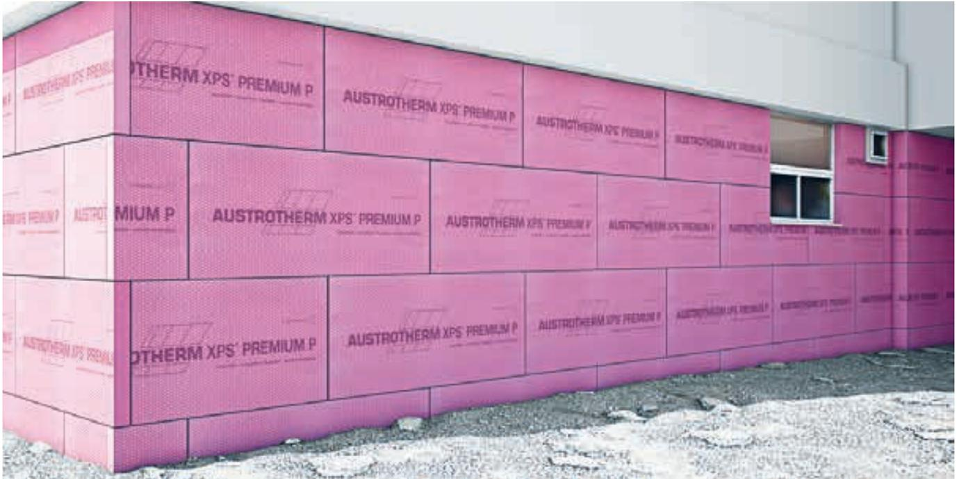
Der Fassadenbereich gleich oberhalb des Terrains ist besonderen Beanspruchungen ausgesetzt. Eine spezielle Dämmung kann hier ihre Vorteile voll ausspielen.
