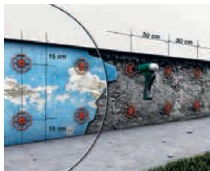
Anbringen vom Baunit KlebeAnker Orange auf dem Mauerwerk bzw. auf dem tragfähigen Untergrund.
