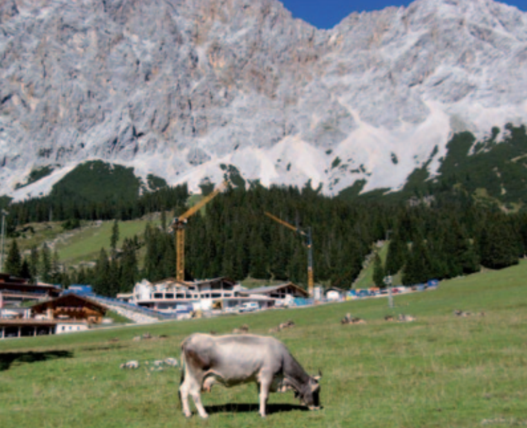
Fotos: Heinz Zanesco (Tirolerhaus, Ehrwalderalm, Gefälledach in Bau)
