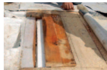
Schäden bei nicht fachgerechter WDVS-Verklebung an der Attika.
