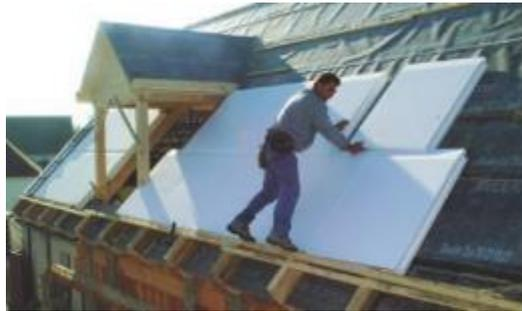
Höchst druckbelastbares Aufsparrendämmelement aus expandiertem Polystyrolhartschaumstoff
