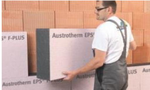
Höchstwärmedämmende Fassadendämmplatte aus expandiertem Polystyrolhartschaumstoff mit **Protect-Beschichtung**
