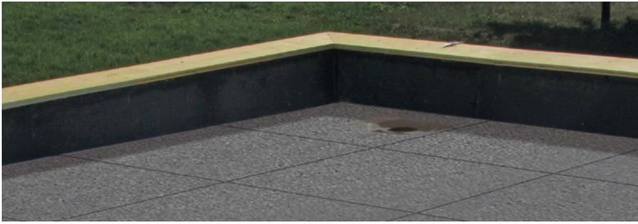
Flachdächer sind mit einem Gefälle auszuführen. Dieses kann entweder durch die Unterkonstruktion (Decke-Gefällebeton) oder mittels Austrotherm EPS® W30-PLUS Gefälledach über der Austrotherm Resolution® Flachdachdämmplatte ausgeführt werden.
