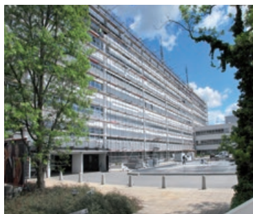
Mit beschichteten Austrotherm Fassadenelementen wurde die originale Optik der Fassade des ORF-Zentrums Königberg erhalten und gleichzeitig thermisch saniert.
