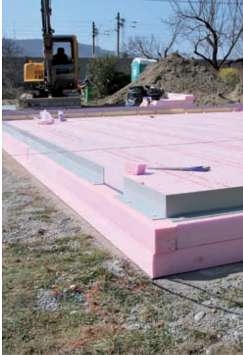
Eine gute, wärmedämmende Basis sorgt für Standsicherheit, hier mit dem neuen Austrotherm Fundamentplatten Dämmsystem.
