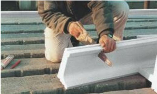
Wärmedämmendes Schalungselement aus expandiertem Polystyrolhartschaumstoff
