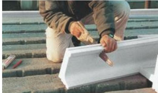
Wärmedämmendes Schalungselement aus expandiertem Polystyrolhartschaumstoff
