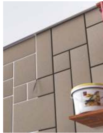
Configurarea îmbinărilor cu vopseaua de exterior
