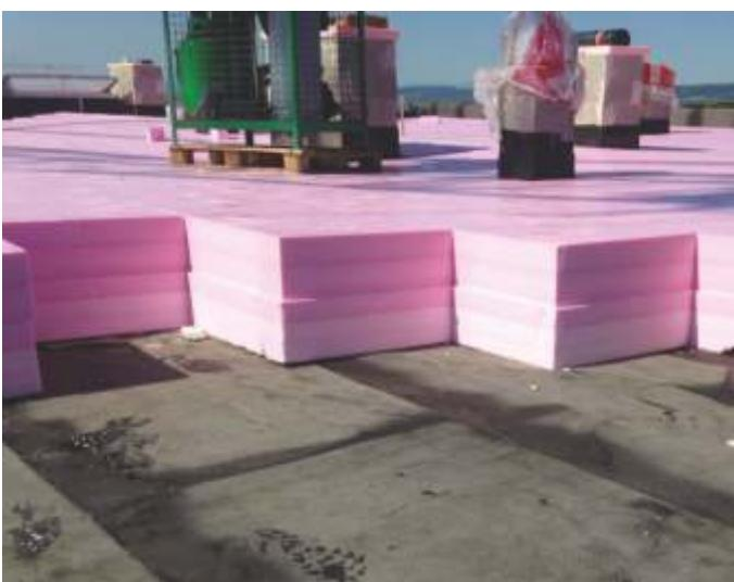
Rezultatul îl reprezintă noul "Austrotherm XPS® Premium 30", un produs cu 23% mai eficient termic decât polistirenul extrudat XPS standard. Avantajele sale intră în joc în special acolo unde spațiul este limitat. Noile plăci XPS, cu un înalt grad de izolare termică, rezistente la compresiune și la apă, oferă o izolare perfectă și economisesc spațiu.
