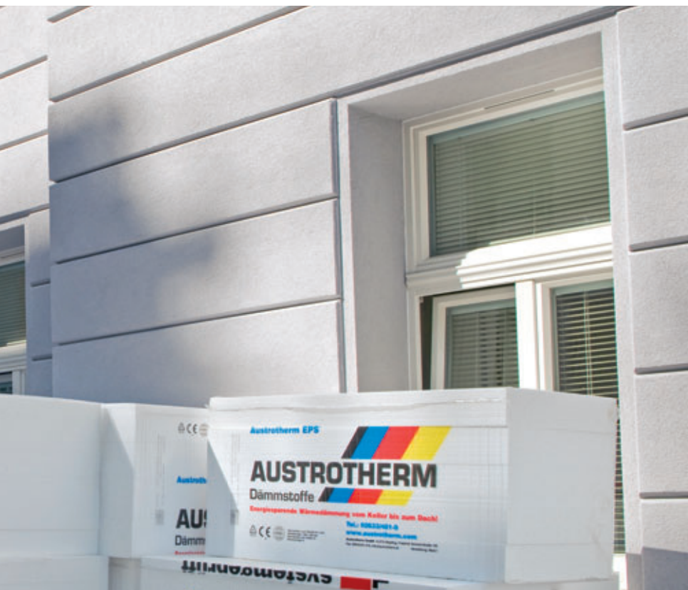
Ein Vorbild für thermische Sanierung bei gleichzeitiger Erhaltung der historischen Fassadenansicht ist diese Wohnhausanlage in der Wiener Robert-Blum-Gasse.
