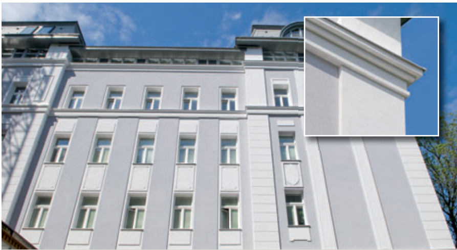
28 verschiedene Zierelemente wurden nach Originalvorlagen von Austrotherm® gefertigt.
