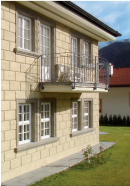
Vollflächig aufgebrachte Bossensteine haben zusätzliche Dämmwirkung.
