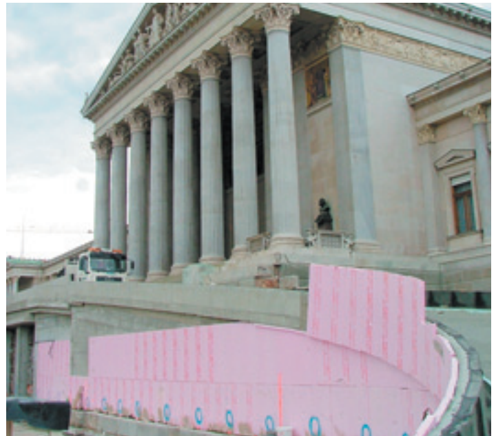
Kerndämmung für die Generalsanierung des Parlaments: Austrotherm TOP® 30 Dämmplatten.
