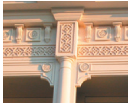
Die ganze Fassade mit Austrotherm Profilen gestaltet.
