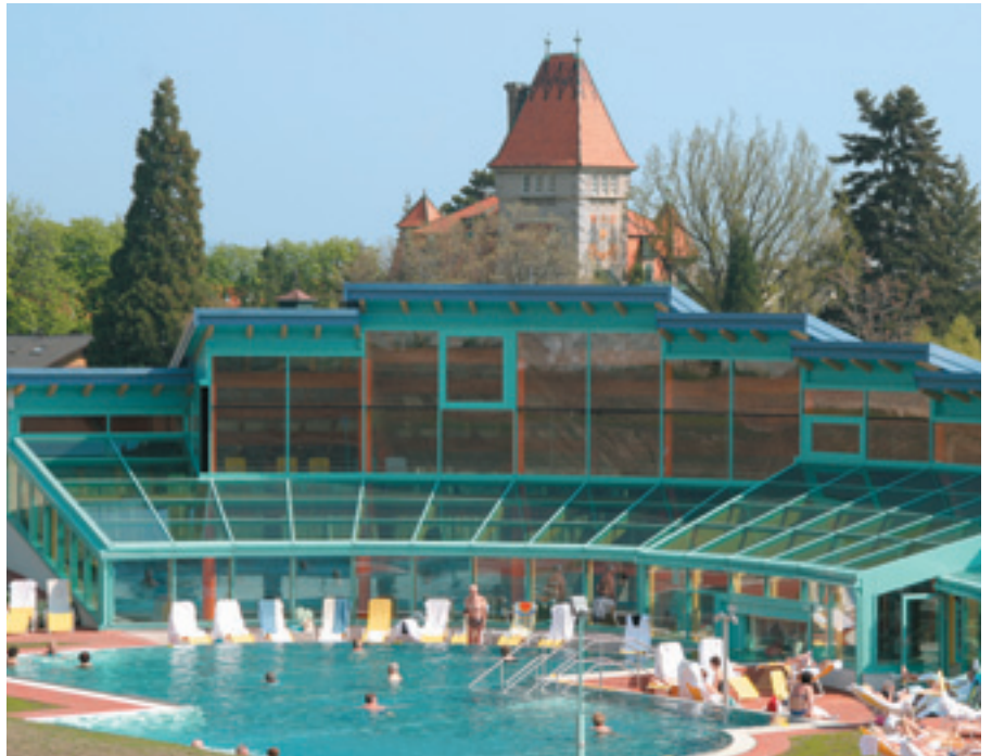
Das Kurzentrum Bad Vöslau auf 255 m Seehöhe.
