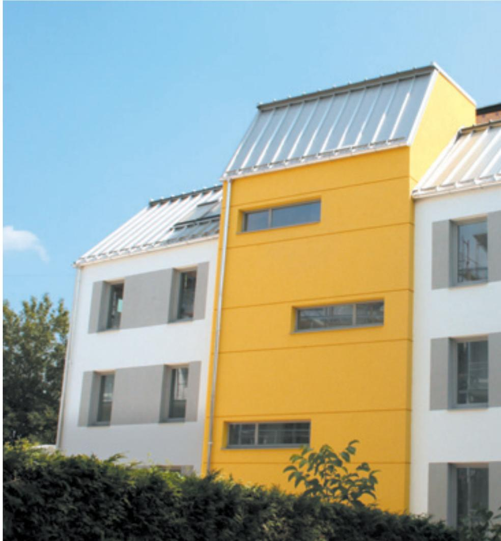
Sozialer Wohnbau ist auch in Passivhausbauweise erschwinglich. Das beweist das neue Passivhaus in der Utendorfgasse in Wien-Penzing. Die Fassade wurde mit 27 cm dickem Austrotherm EPS® F-PLUS gedämmt.
