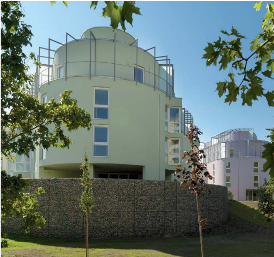
Gut gedämmt: Passivhauswohnanlage „Melone“ in Wien
