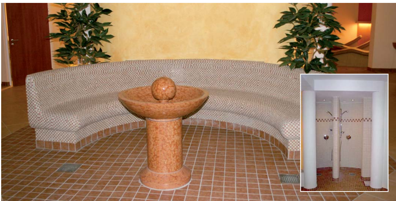
Ausstattung des Schwimmbads in Schwaz in Tirol mit Austrotherm Wellness Elementen
